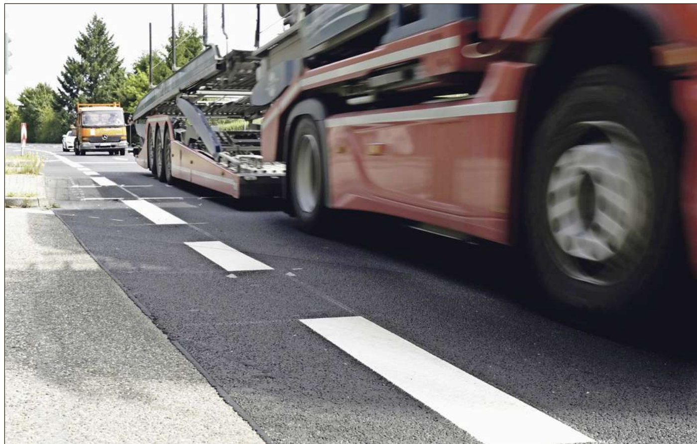
Die sanierte Badener Straße: Die Schlaglöcher sind beseitigt; der Flüsterasphalt erzeugt dumpfere Geräusche.
